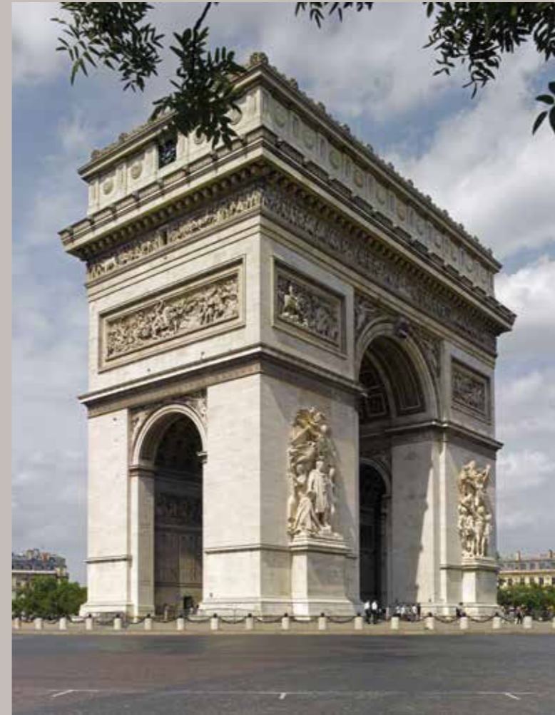
L'Arc de triomphe, côté sud-est, depuis l'avenue d'Iéna
