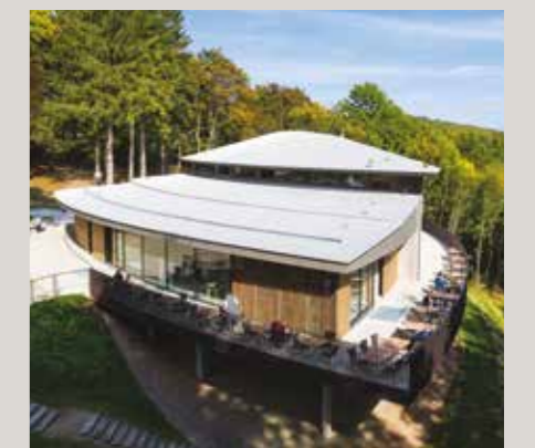
Historial du Hartmannswillerkopf Vue extérieure
