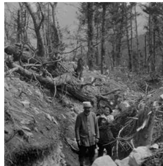
Tranchée bouleversée, Hartmannswillerkopf, sommet des Vosges
